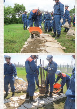
積み土のう工法
